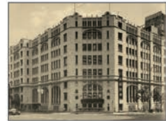
旧肥後橋本社ビル (設計:W・M・ヴォーリス)
