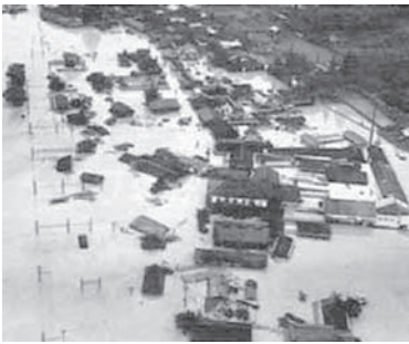
天竜川の氾濫で水に浸かった川路駅周辺
